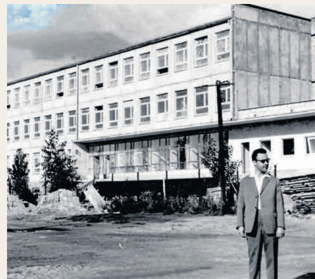
► Edward Cyrklaff bacznie obserwuje budowę szkoły, do której niebawem mają przyjść jego dzieci (zdjęcie wykonała żona). Widać materiały budowlane oraz brak okiennic w mieszkaniach służbowych. Nie ma także jezdni - 1963 rok
